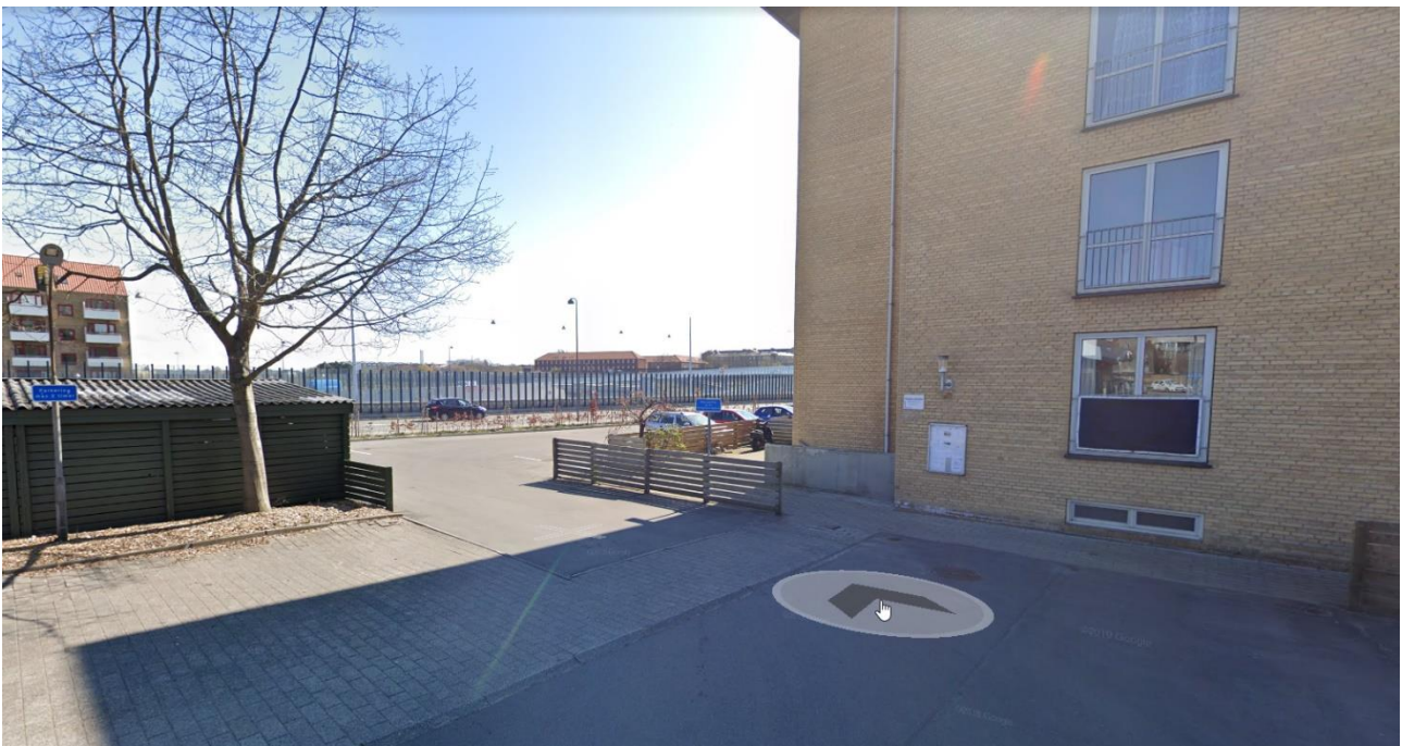
Figur 5: Nuværende kantsten og betonstensbelægning omkring indkørsel til AABs P-plads, som omlægges.
