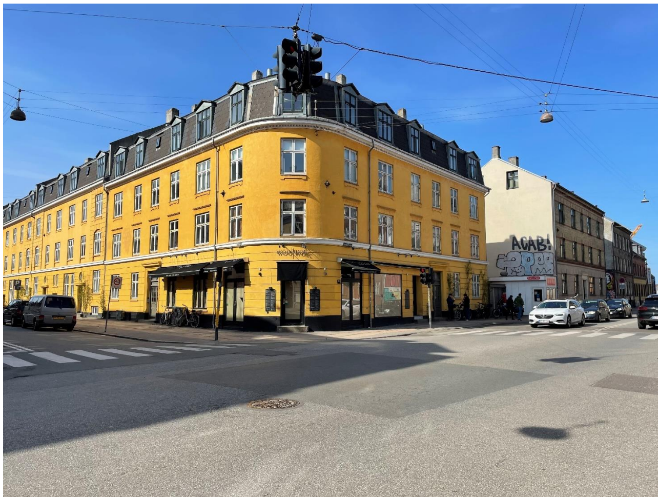
Hjørnet Nordre Fasanvej 267 og Ørnevej 4-12. Bebyggelsen er fra begyndelsen af 1900-tallet med afrundet hjørne og mansardtag. Begge er stedstypisk for området. Etagehøjden er lavere end de øvrige brokvarterer, ligesom stueetagen ofte også er lavere. Brønshøj Sogn havde indtil 1940 dispensation i deres byggelovsbestemmelser i henhold til deres byggereglement fra før indlemmelsen i 1901.
