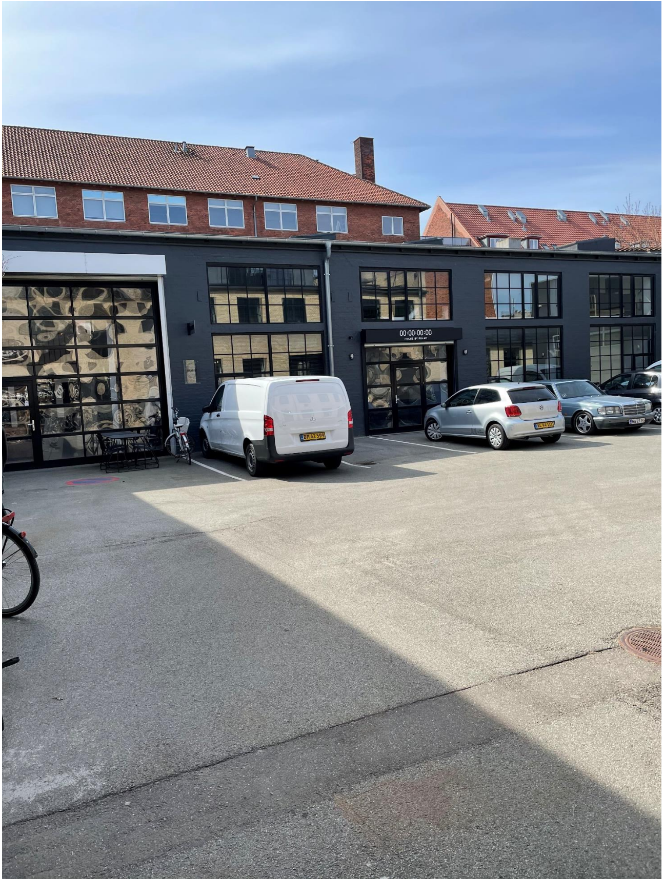
Baghuse til Glentevej 45-51
