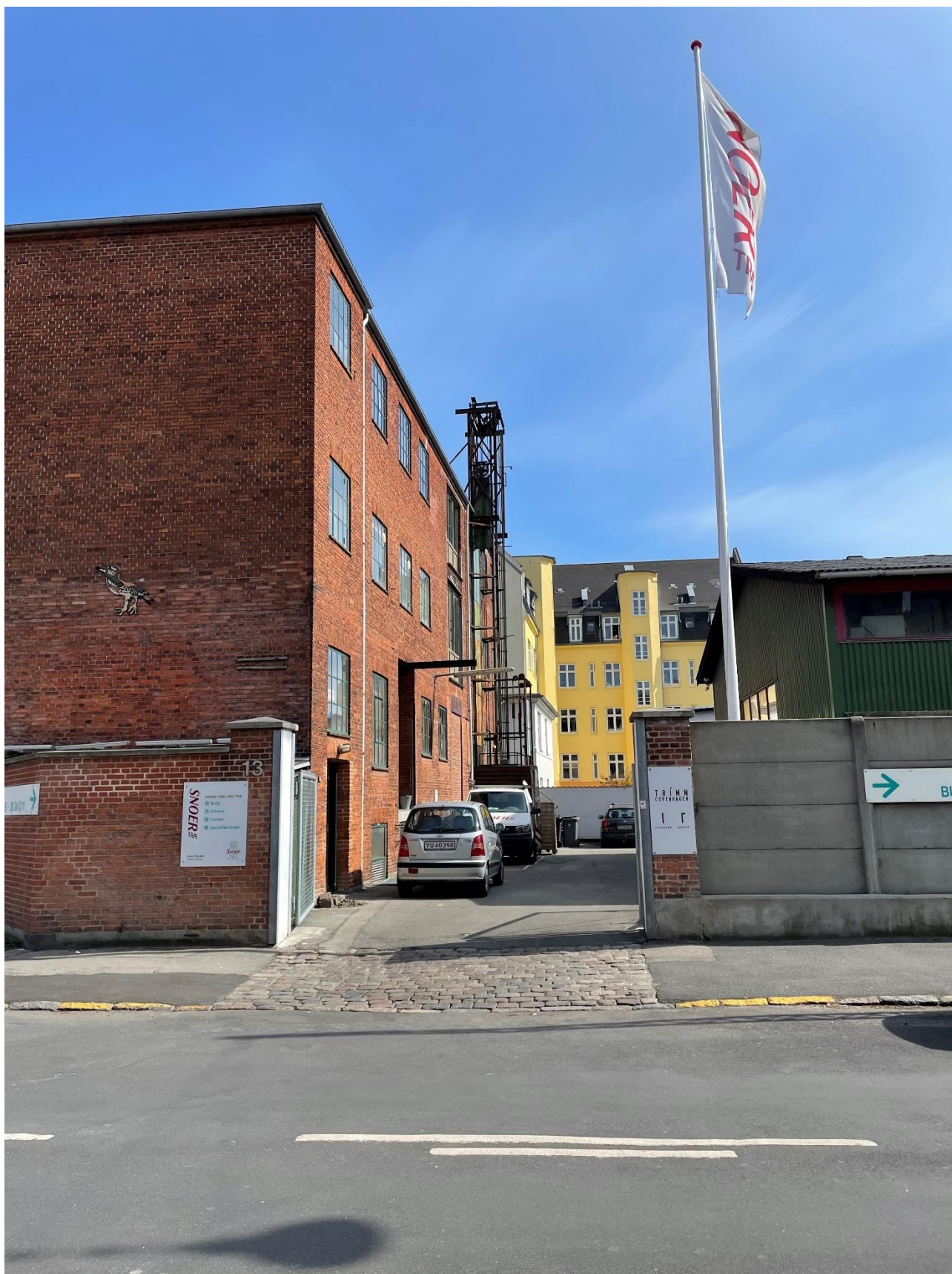
Den udvendige elevator fra o. 1959 på bagsiden af fabriksbygningen.
