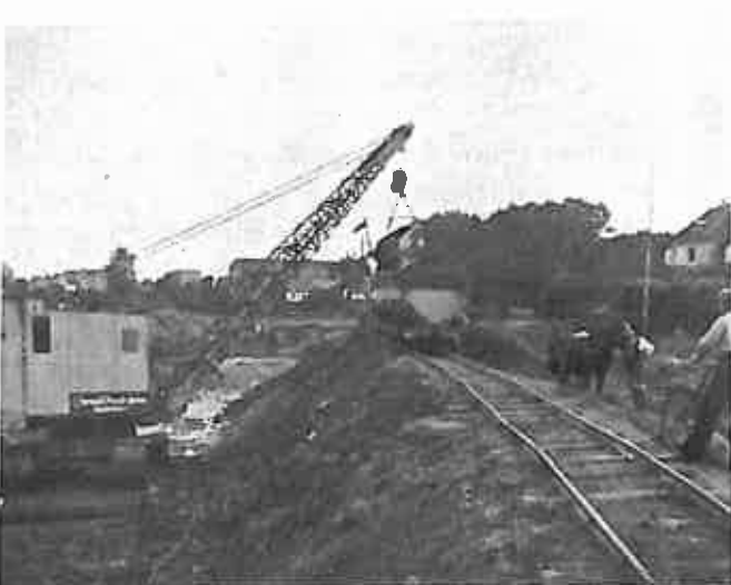
Udgravning af Kanaler omkring et af Opfyldningsarealerne.
