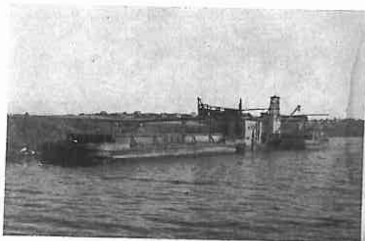
Indpumpning af Fyld paa Optyldningsarealet.
