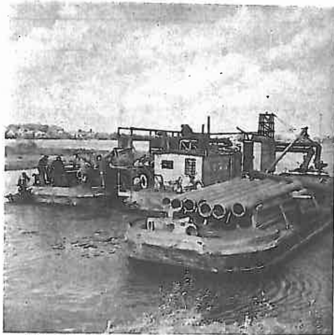
Pumpeanlægget og den lange Rørledning rigges til.
