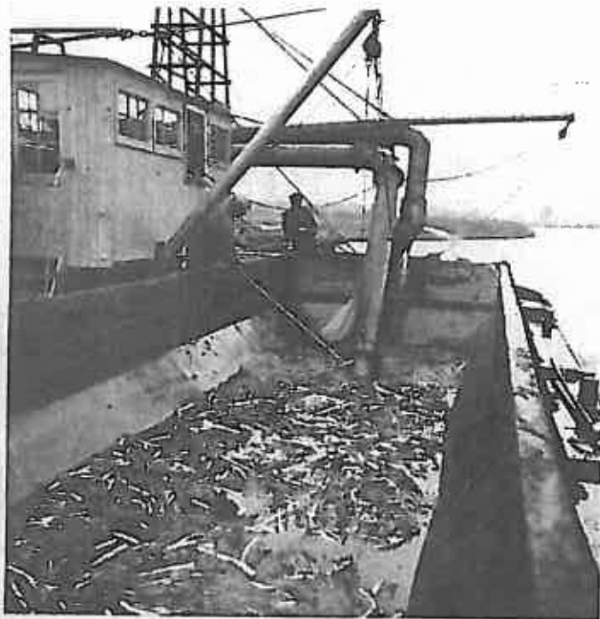
Det flydende Pumpeanlæg tømmer en Pram for den opgravede og sønderdelte Fyld.
