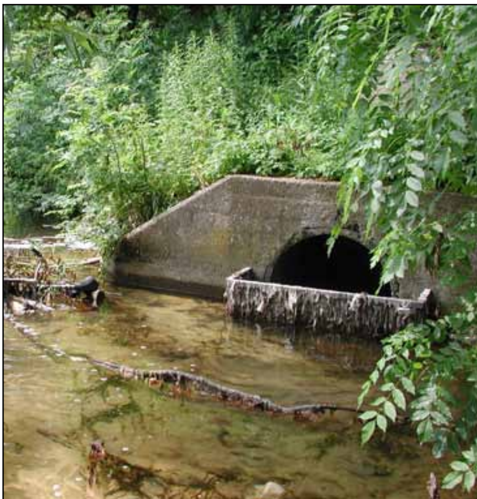
Et overløbsbygværk (fra 2)
